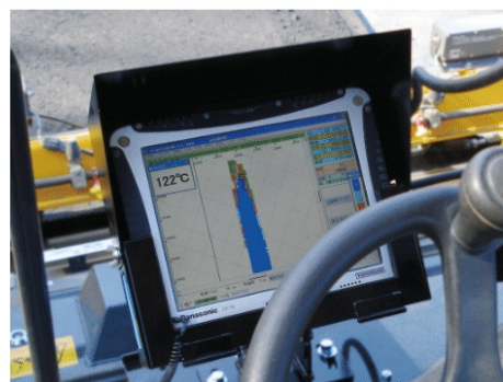
オペレータは画面の色を見ながら転圧するだけです
